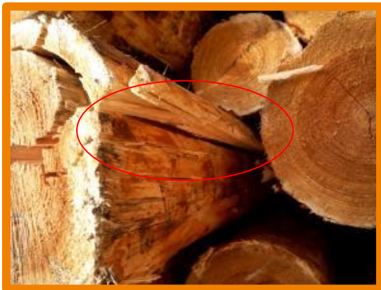
Risse entlang der Mantelfläche
